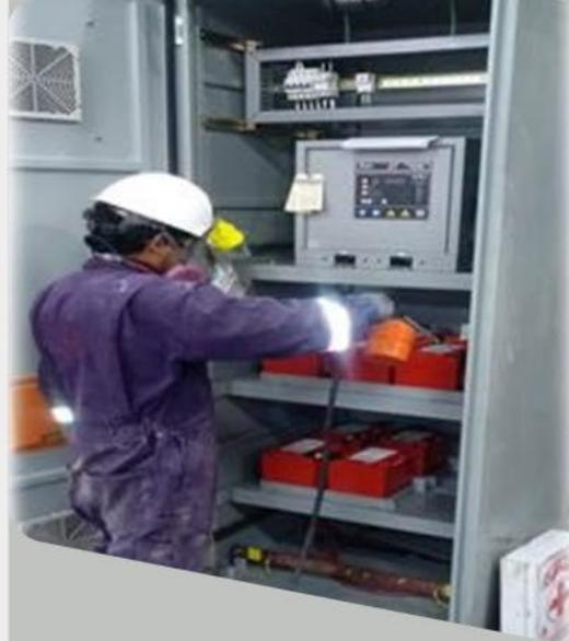
Realizamos el mantenimiento y pruebas de impedancia y descarga de Bancos de Baterias.
