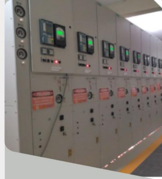
Llevamos a cabo el montaje, acoplamiento, interconexión y pruebas eléctricas de celdas de MT.
